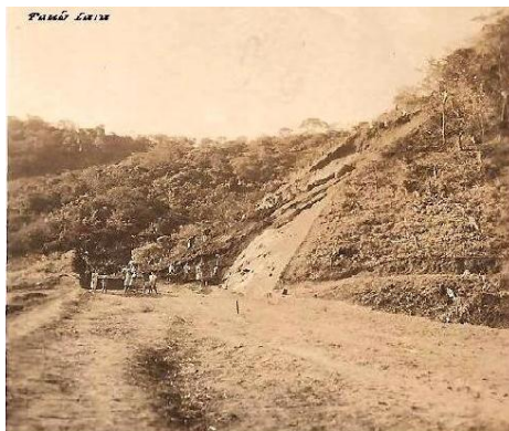
Obra de construção da RJ-14
