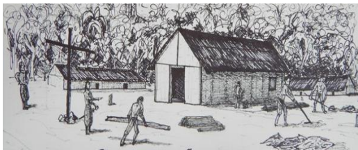
Construção da capela de n. S. da Guia por Miguel Arturo
